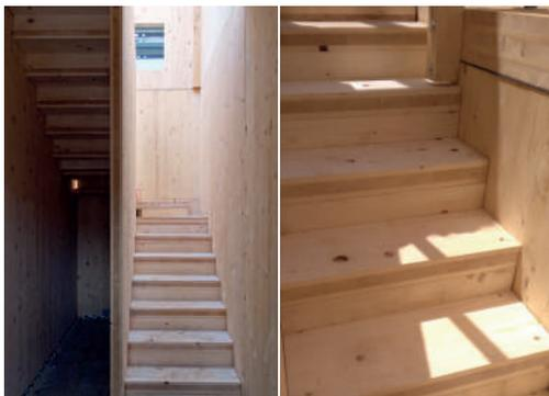
Le scale a giorno o ad angolo vengono prodotte con una struttura massiccia che funge da scala di cantiere per poi essere rivestite con elementi in legno o pietra a scelta del cliente.
