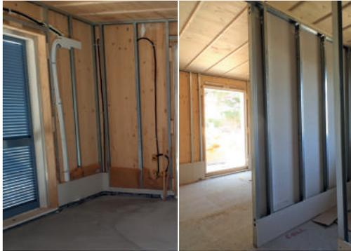
I tramezzi interni vengono realizzati con struttura metallica e doppia lastra di cartongesso, o di gesso fibrato, per ciascuna faccia, con interposta coibentazione insonorizzante.
