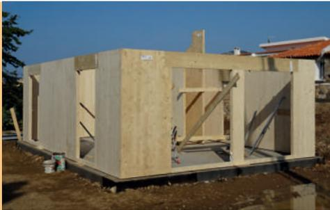
Il montaggio della struttura XLam avviene con gru edili o autogrù. I pannelli sono fissati tra di loro e al basamento in calcestruzzo con connessioni calcolate per resistere agli sforzi prescritti dalle normative vigenti in materia di carichi permanenti e di azioni accidentali (sisma, neve e vento).
